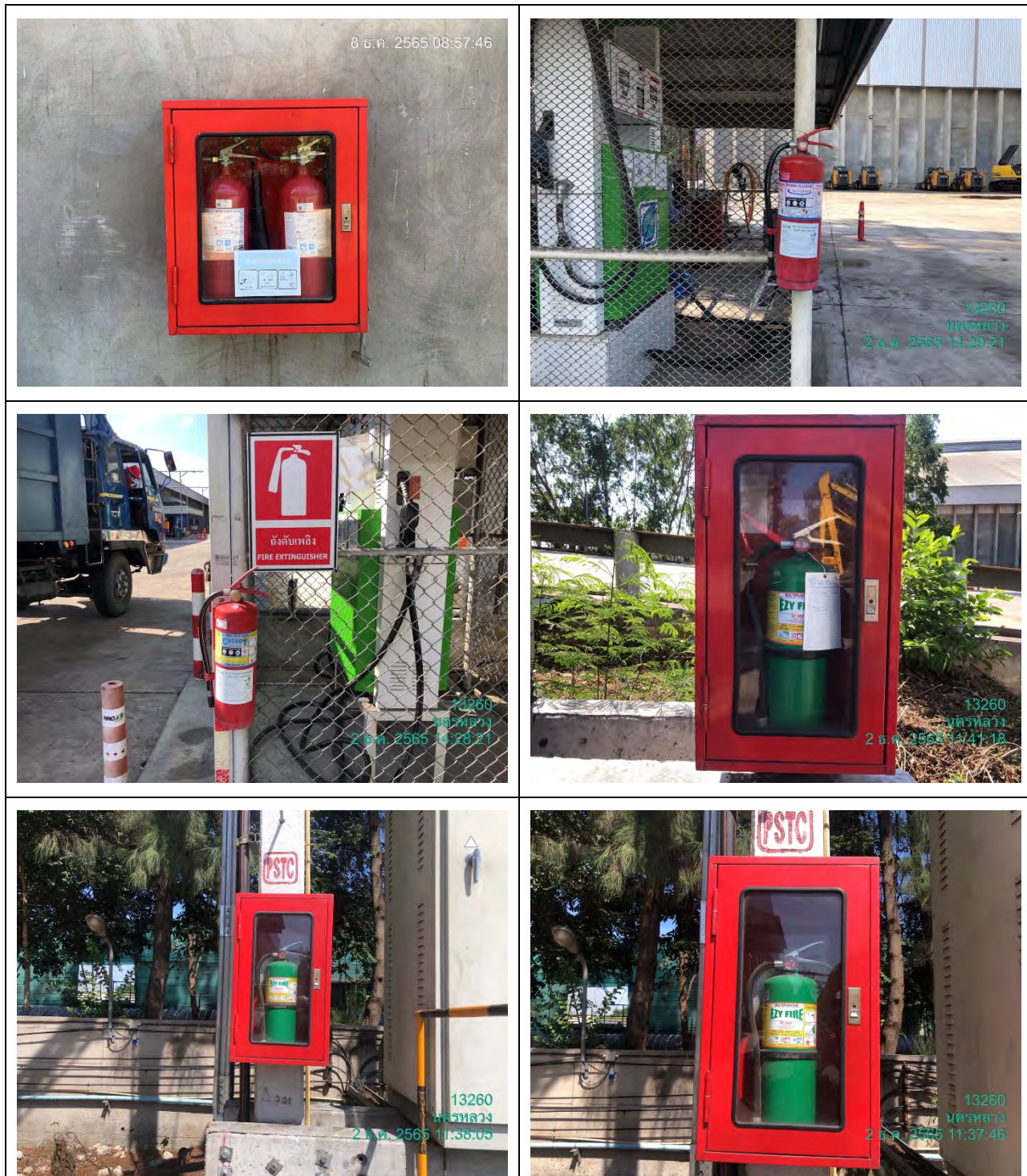
รูปที่ 2.2-73 ถังดับเพลิงชนิดผงเคมีแห้ง ขนาดบรรจุ 10 ปอนด์ ถังดับเพลิงชนิดก๊าซคาร์บอนไดออกไซด์ ขนาด 10 ปอนด์ และถังดับเพลิงชนิดน้ำยาเหลวระเหย (BF2000) ขนาด 10 ปอนด์
