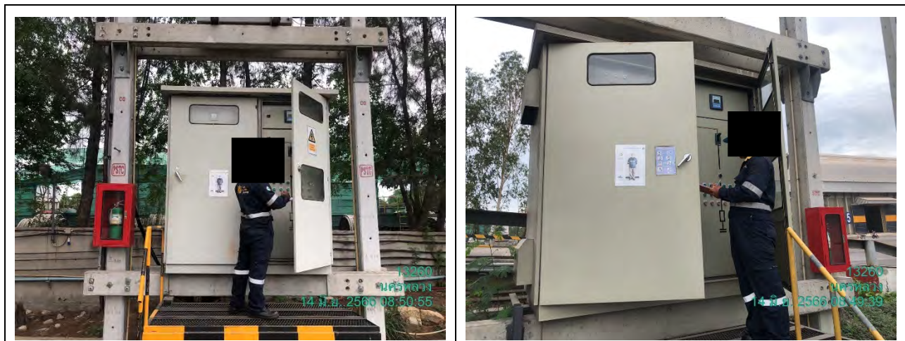
รูปที่ 2.2-42 การตรวจสอบ บำรุงรักษาไฟฟ้าแสงสว่างบริเวณท่าเทียบเรือ
