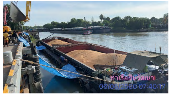
รูปที่ 2.2-17 การชิงผ้าใบหรือผ้าพลาสติกระหว่างเรือลำเลียงสินค้าและท่าเทียบเรือ
